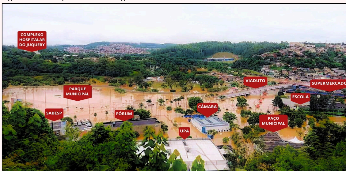
Figura 1: Inundação de 2022 na região central de Franco da Rocha.
