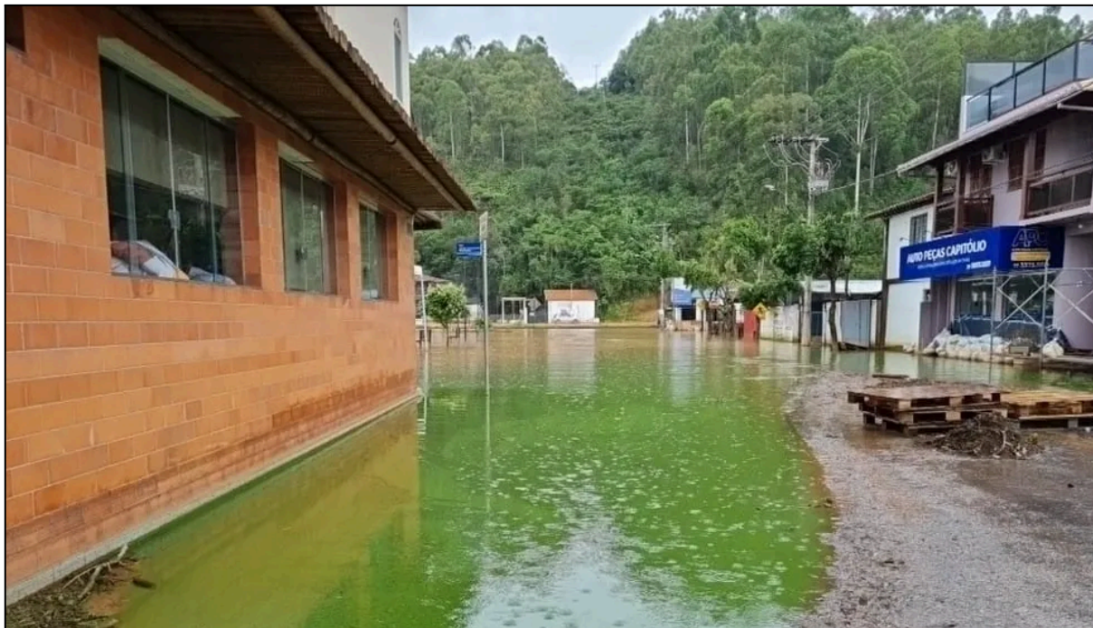
Figura 1 - Alagamento em ruas de Capitólio após transbordamento do Rio Piumhi.
