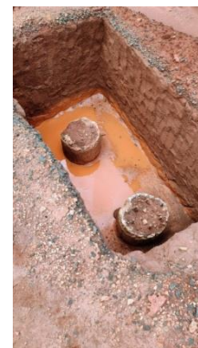
Figura 5. Sapata com tubulões sem sinalização - risco de queda e acidentes (risco de acidente).
