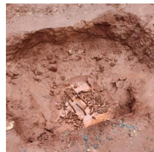
Figura 5. Sapata com tubulões sem sinalização - risco de queda e acidentes (risco de acidente).
