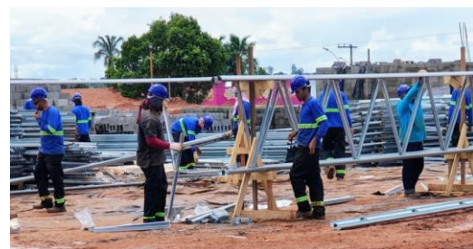
Figura 23. Trabalhadores sem luvas em esforço físico - risco de acidentes e lesões (risco ergonômico e de acidente).
