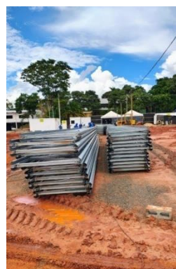
Figura 17. Extensão elétrica em contato com água - risco de choque elétrico.
