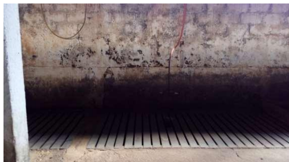
Figura 5. Uso de piso de cimento e ardósia na instalação.
