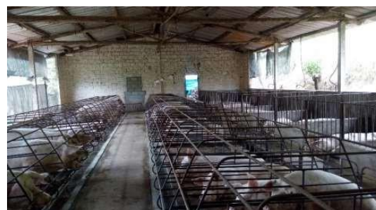
Figura 3. Altura de pé-direito em instalações com telhado de amianto.
