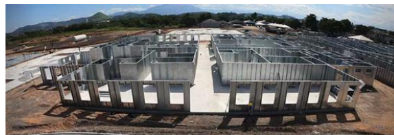
Figura 3. Construção do hospital Dr. Ricardo Cruz (Fonte: Quick House , 2020)
