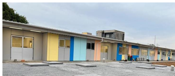
Figura 22 – Acabamento final Fonte: Quick House (s.d.)
