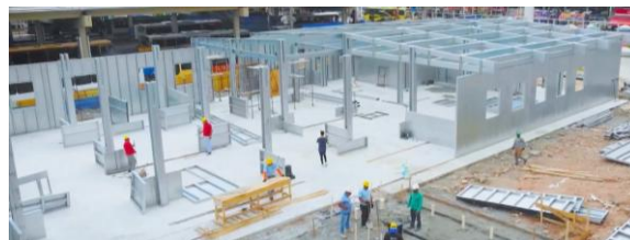
Figura 4. Construção do restaurante popular do Rio de Janeiro (Fonte: Quick House , 2024)
