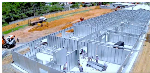
Figura 15 – Escola em construção (Fonte: Quick House, s.d.)
