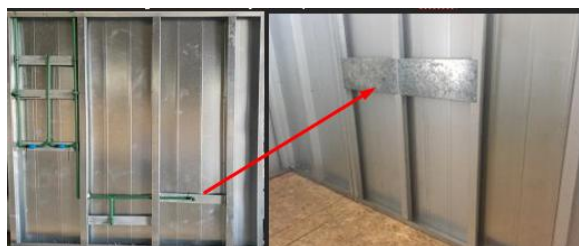
Figura 20 – Reforços estruturais (Fonte: DATec nº 049A/IPT, 2024)
