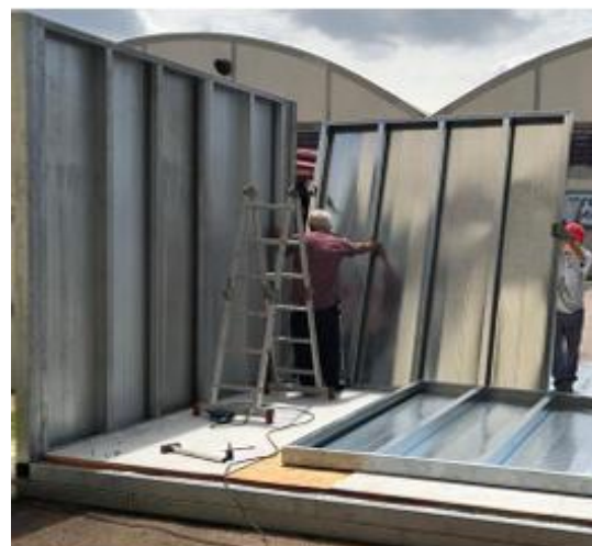
Figura 14a – Montagem das paredes (Fonte: IPT, 2024)
