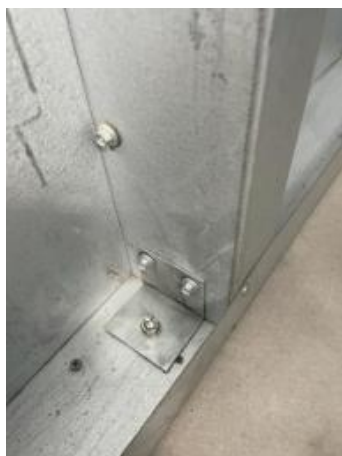
Figura 13 – Fixação da parede ao piso (Fonte: DATec nº 049A/IPT, 2024)
