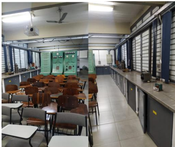
Figura 1. Visão interna do laboratório de Engenharia Elétrica da UEMG.
