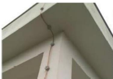
Figura 2. Condutor de descida.
