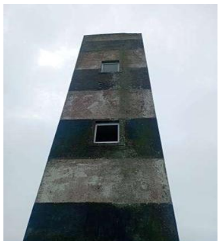
Figura 2 - Vista geral da estrutura de concreto armado localizada na Ilha de Galé, Bombinhas/SC
