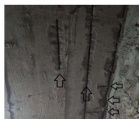
Figura 5. Representação de corrosão de armadura.
