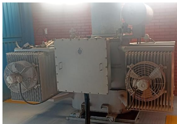
Figura 5. Ventiladores acoplados nas aletas de óleo.
