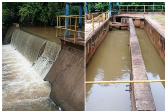
Figura 3. Barragem de nível no Ribeirão São Lourenço e caixas de retenção de areia.
