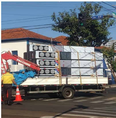
Figura 9. Estruturas a serem instaladas.
