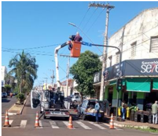
Figura 8. Caminhão munck usado para transporte das estruturas e operações em alturas.
