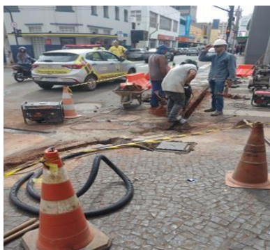
Figura 10. Construção da passagem de fiações via rede subterrânea.
