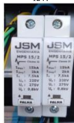
Figura 2.4. Controlador JSM - Dispositivo de proteção contra surtos elétricos (DPS).
