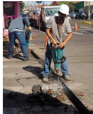
Figura 11. Construção da passagem de fiações via rede subterrânea.
