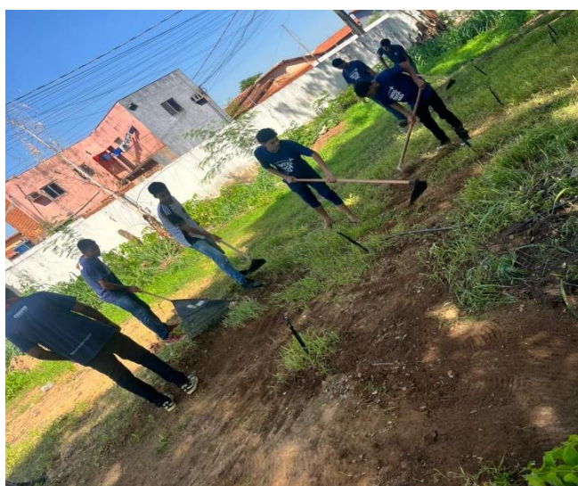
Figura 2 – Limpeza da área dos canteiros.
