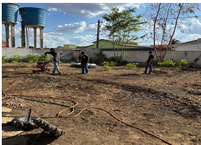
Figura 3 – Destorroamento do solo com arador.
