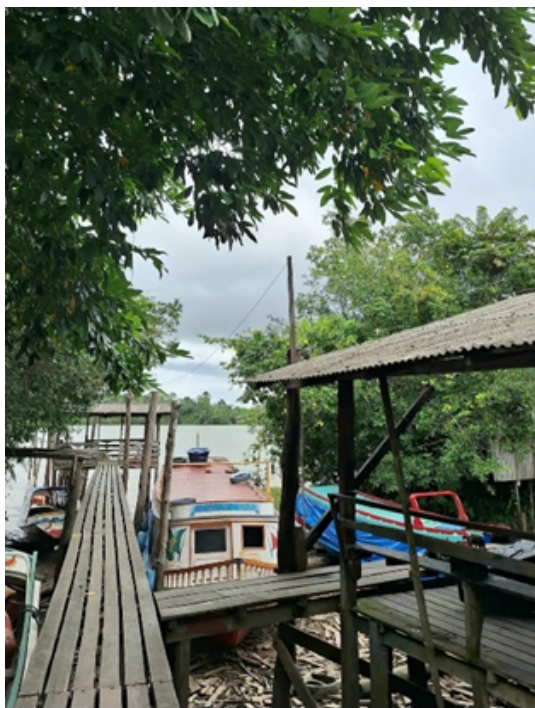
Portos com os sistemas de ponte, maloca e miritizeiro Fonte: os autores, 2024
