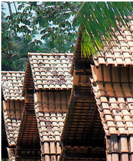
Figura 4: Telhado com lanternim e beiral
