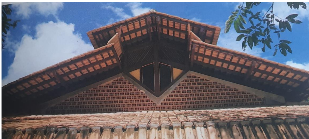
Figura 7: Estrutura do beiral e lanternim do Retiro Tagaste
