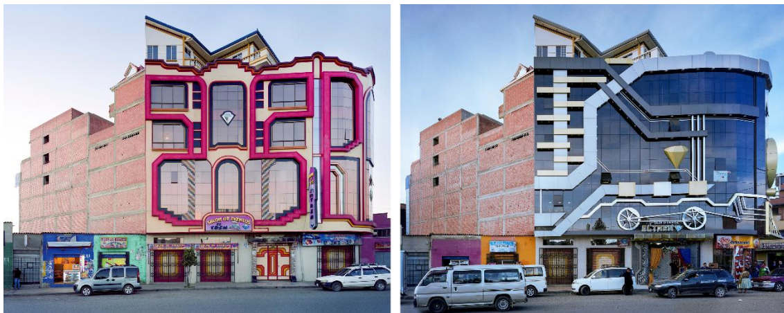
Figura 2: Fachadas dos edifícios
