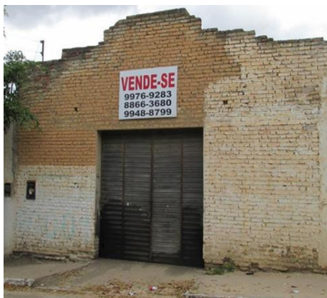
Fachada de antigo salão de destalação com tijolos aparentes. Fonte: Santos (2020)
