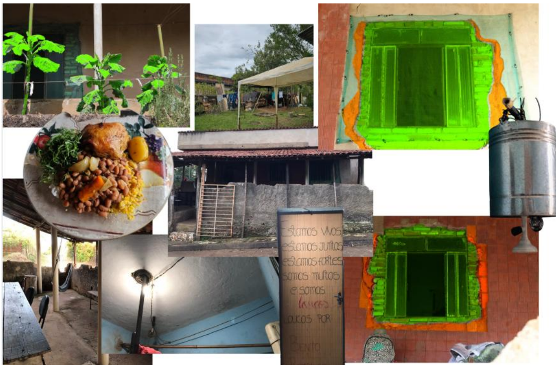
Algumas das fotografias da Casa dos Loucos por Bento receberam um tratamento visual, buscando evidenciar aspectos da reconstrução específicos (como a complementação dos vãos por tijolos e a inserção de novas esquadrias)
