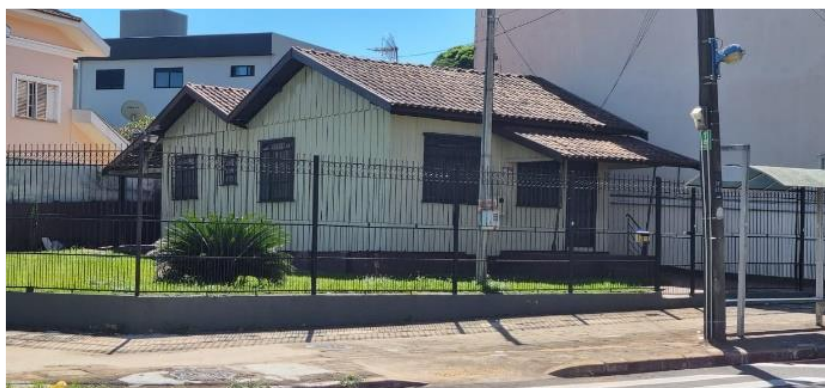
Figura 11 - Edificação localizada na Avenida Laguna, quadra 29 - lote 1.
