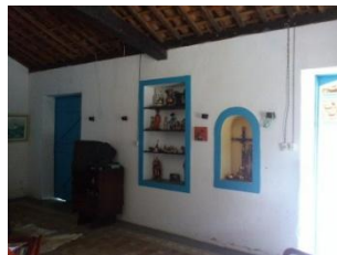
Figura 8. Paredes espessas das casas vernaculares.
