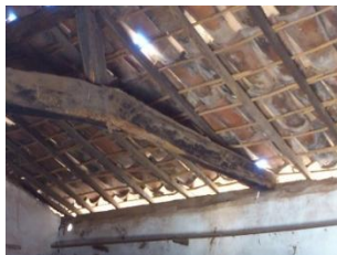
Figura 7. Sistema de telhado apoiado sobre o brabo.
