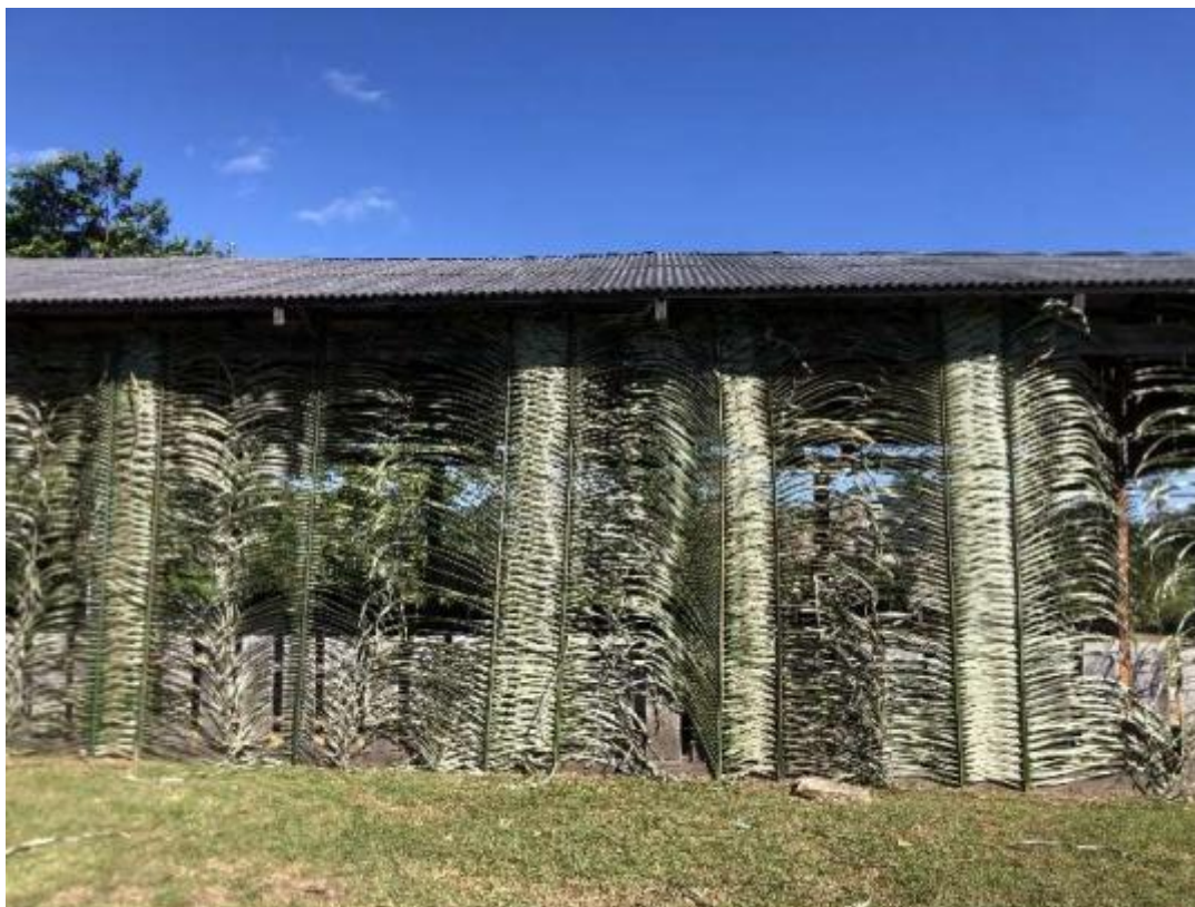
Figura 3: Sistema de fechamento em palha na Casa de Apoio
