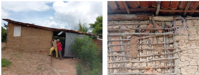
Figura 4: Edificação em pau a pique.
