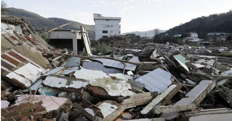
Figura 4: Destruição causada pelas enchentes em Muçum (RS), junho de 2024.
