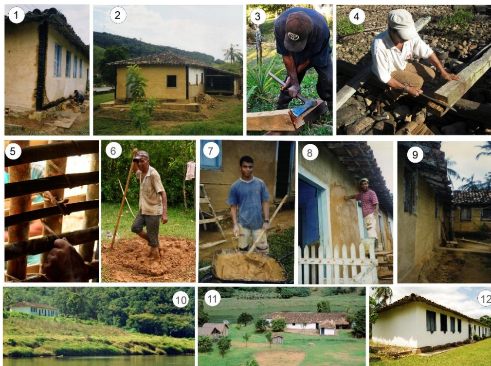
Figura 6: Processo de restauração e requalificação da edificação em 1998.
