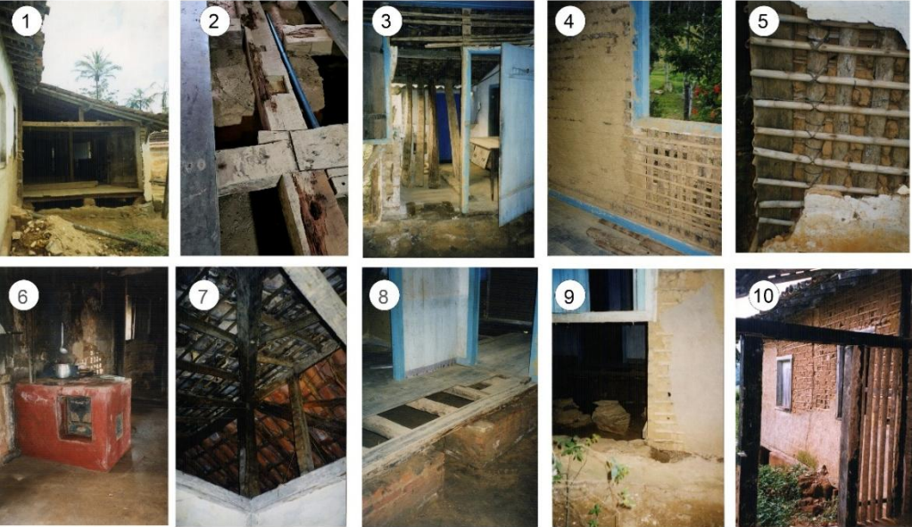
Figura 2: Detalhes do sistema construtivo da fazenda Passagem.
