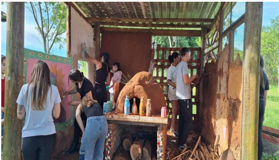
Figura 3: Processo coletivo de experimentação de técnicas construtivas em terra no Canteiro Experimental
