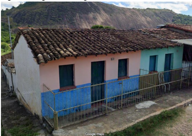
Exemplo de uma edificação classificada na categoria 2 devido a sua tipologia de cobertura típica de casas construídas com terra Fonte: elaborado pelas autoras.
