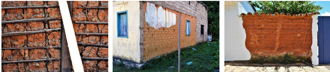
Figura 2: Técnicas construtivas de terra
