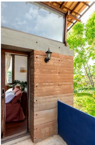
Parede de taipa de pilão empregada como elemento estruturante do partido e como dispositivo de moderação térmica. Fonte: AzulPitanga, 2021.
