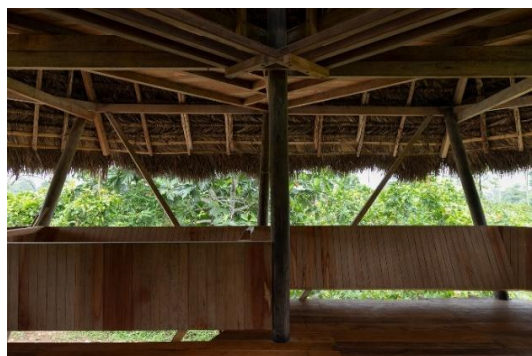
Figura 3: Biblioteca Yuyarina Pacha: interior e detalhe da cobertura.
