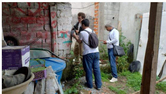
Figuras 13 e 14: Trabalho de levantamento das dimensões da casa de Dona Sônia, para realização de planta-baixa, cortes e elevações de base. Fonte: Acervo coletivo da disciplina "Projeto e Crítica: a periferia no centro", 2025.
