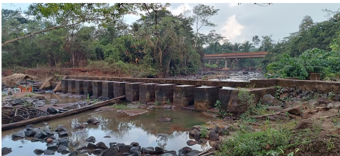
Figura 3: Barragem no leito do rio Seiko na estrutura do balneário.
