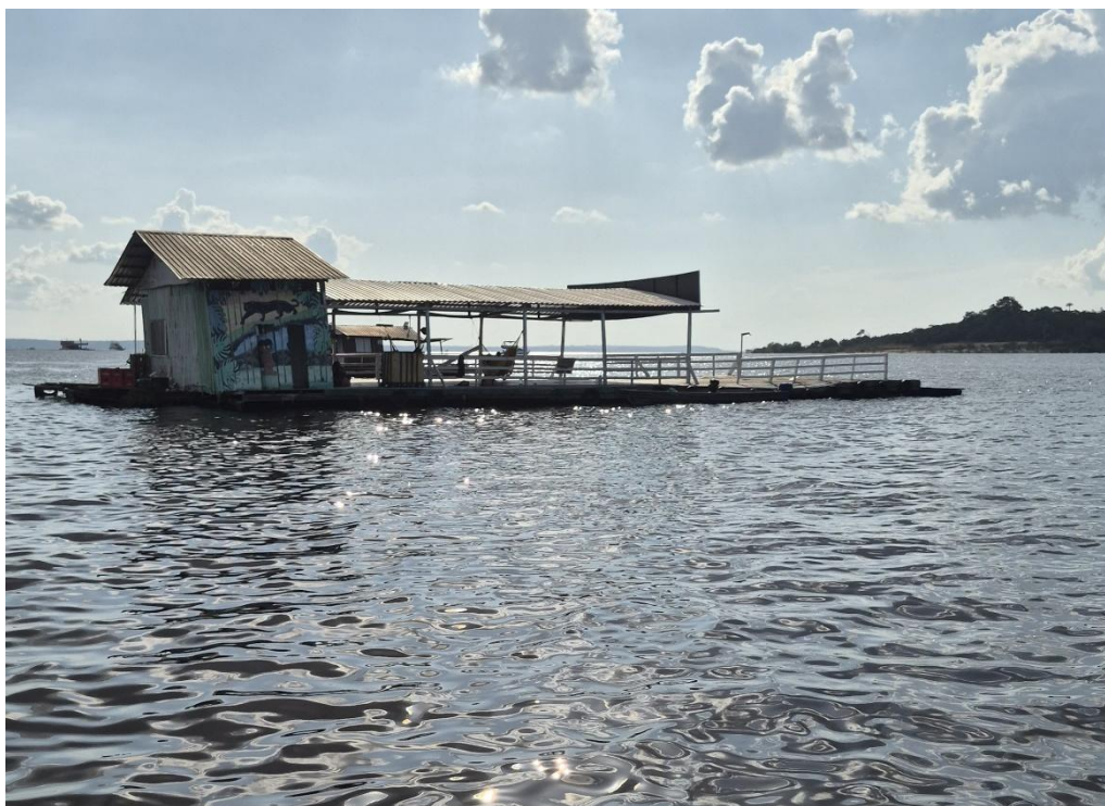
Construção flutuante no Rio Negro, em Manaus/AM. Fonte: autoras.
