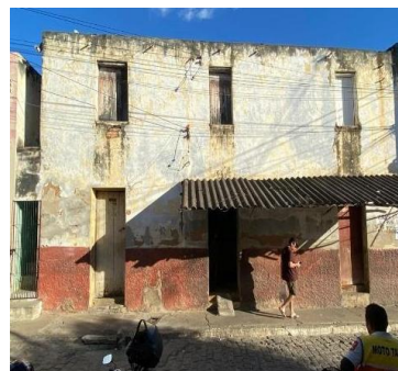
Fachada lateral. Fonte: os autores, 2026.
