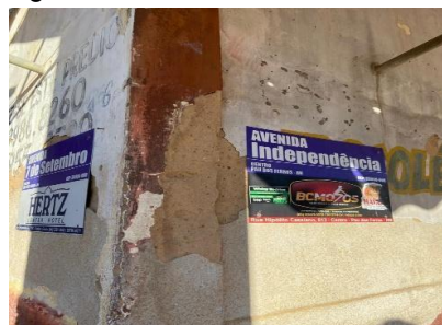
Camadas de revestimentos desgastado Fonte: os autores, 2026.
