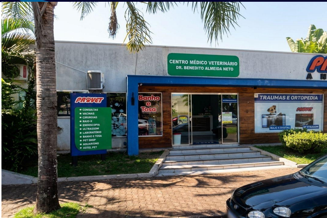
comércio da cidade sem rampa apenas escada sem corrimão
