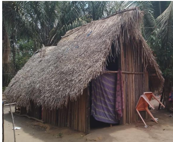
Casa de com paredes em varas e cobertura em palha Fontes: Autores, 2025
