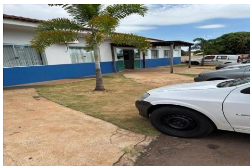
Figura 6 – Rampa de acesso obstruída na Unidade Básica do município do interior do Paraná. Fonte: Autoria própria (2026).
