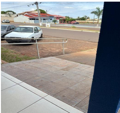
Figura 3 – Entrada do Hospital do município do interior do Paraná
