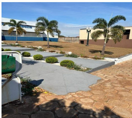
Figura 1 – Acesso com rampa na Prefeitura Municipal do município do interior do Paraná.
