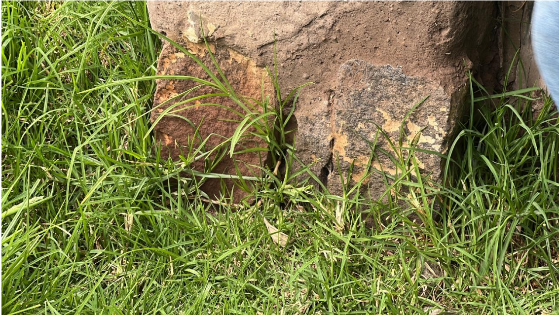
Figura 4: Fundação superficial em pedra.
