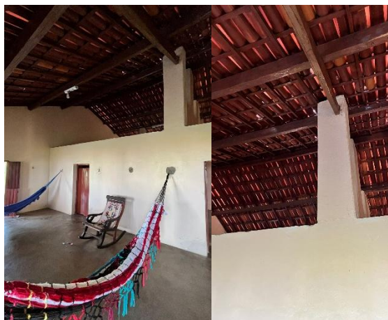
Figura 06 – Parte vazada da alvenaria que permite ventilação Fonte: Produzido pelos Autores (2026).
