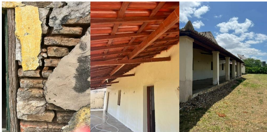
Figura 04 – Parede com tijolo original à mostra; madeiramento do telhado: alpendre lateral (Oeste). Fonte: Produzido pelos Autores (2026).
