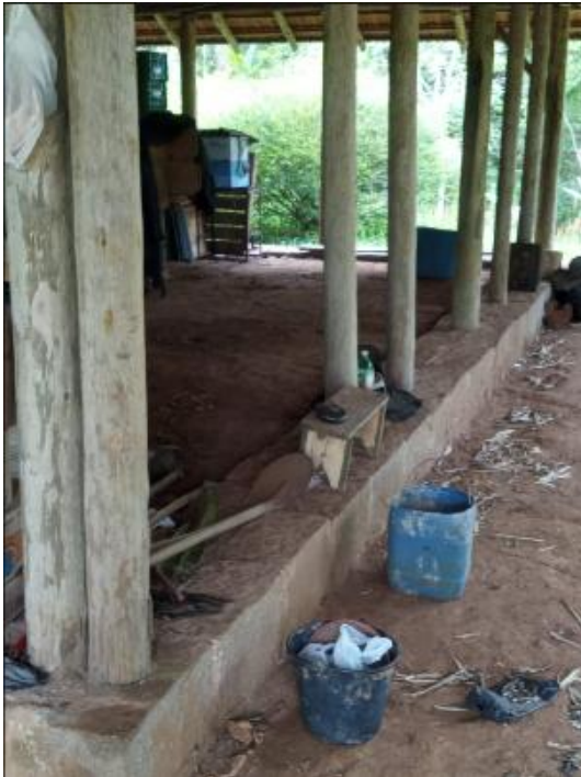
Figura 4: Estrutura Baldrame de Pedra
