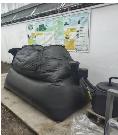
Figura 2 – Biodigestor utilizado no tratamento de resíduos orgânicos cozidos
