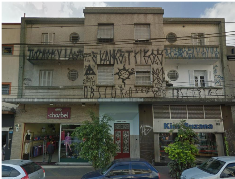
Figura 5: Edifício de uso misto
