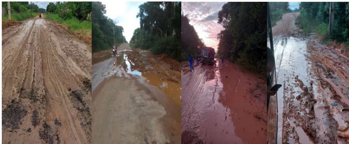
Imagem 01 – Atoleiros em estradas vicinais no Amazonas.
