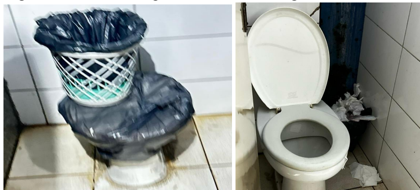
Imagem 2. Banheiros inoperantes da feira. Imagem 3. Banheiro com limpeza
