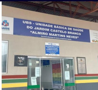
Figura 2 – UBS Jardim Castelo Branco, local da intervenção. Fonte: Galeria Pessoal
