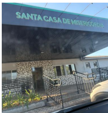
Figura 11- Santa Casa: Acessibilidade com problemas, vagas PcD ausentes. Fonte: Galeria pessoal (2026)
