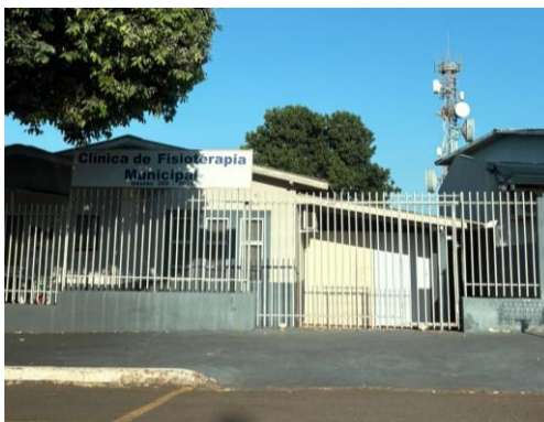
Figura 6- Clínica de Fisioterapia Municipal: falta de acessibilidade externa (sem rampa e sem vaga PcD identificada). Fonte: Galeria pessoal (2026)
