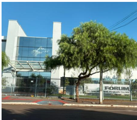
Figura 3- Fórum: identificação de guia rebaixada para PcD e sinalização de acesso externo. Fonte: Galeria pessoal (2026)
