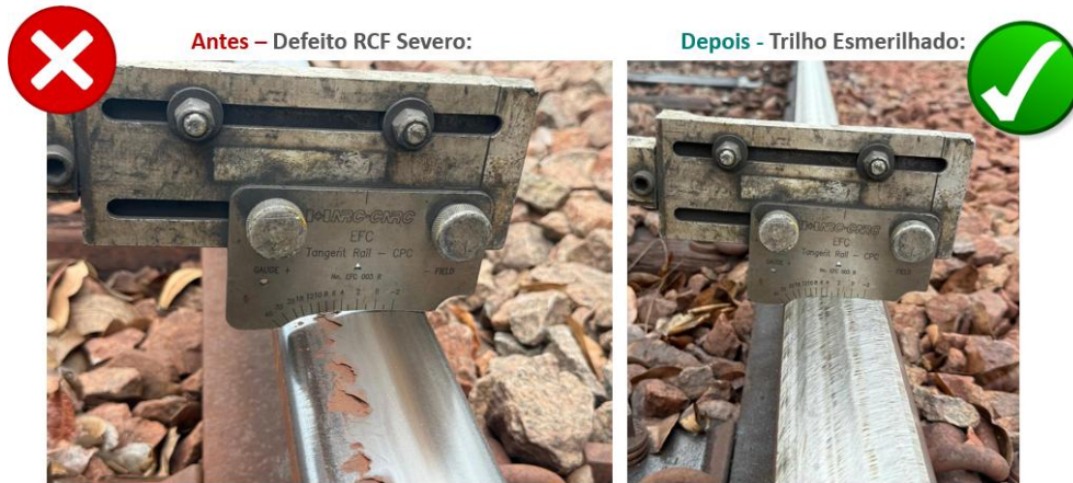
Figura 7. Antes x Depois do Esmerilhamento na região de hot box
