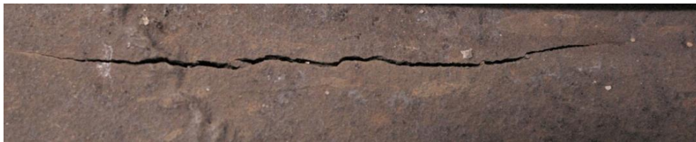
Figura 4. Trinca em disco. Fonte: Dick (2021).
