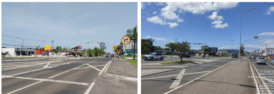
Figuras 24 e 25. PN's com sinalização ativa tipo 4 (campanha e sinal luminoso com controle automático) na Av. Centenário (km 107+082 no Ramal Sangão e km 0+134 no Ramal Fiorita) no Centro de Criciúma.
