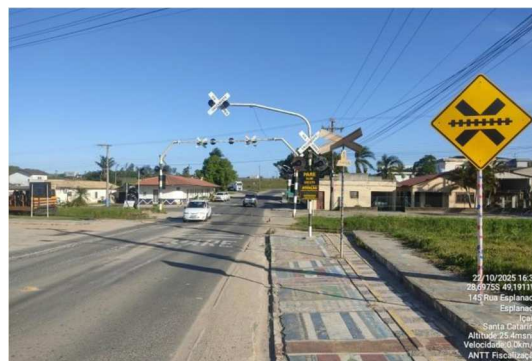
Figuras 20 e 21. PN com sinalização ativa tipo 4 na Rodovia SC-445 (km 85+900) em Içara.
