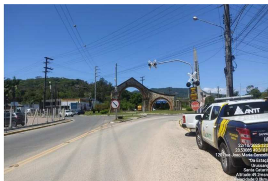
Figuras 22 e 23. PN's com sinalização ativa tipo 3c na Rodovia SC-445 (km 24+263 e km 24+300) em Urussanga.
