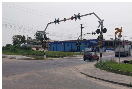
Figuras 20 e 21. PN com sinalização ativa tipo 4 na Rodovia SC-445 (km 85+900) em Içara.
