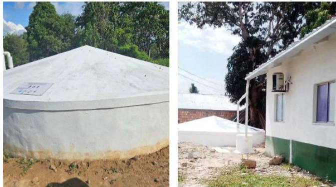
Figura 4 e 5 – Cisterna de placas instalada na comunidade Santa Luzia do Catuiri, Zona Rural do Município de Alvarães/AM.
