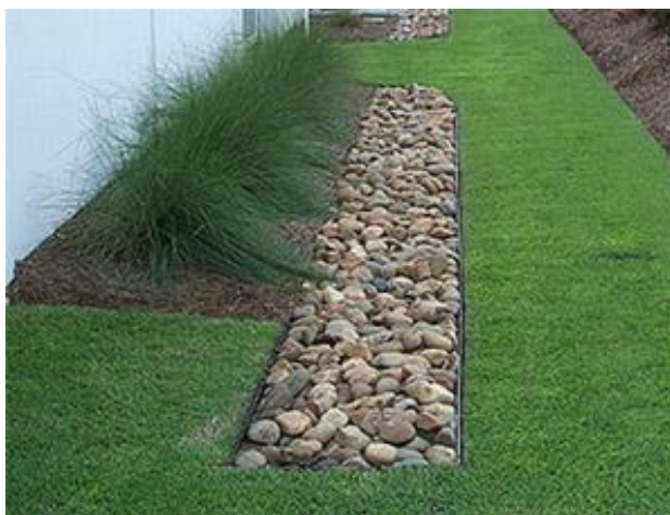
Figura 6: Exemplo de trincheira de infiltração.
