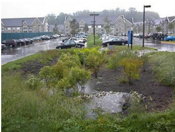
Figura 5: Exemplo de bacia de infiltração no País de Gales.
