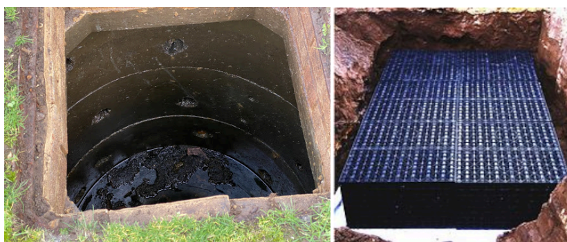
Figura 9: Exemplos de poços de drenagem com anéis de concreto (esquerda) e com caixas plásticas de malha aberta (direita).
