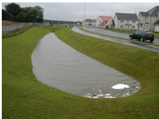
Figura 13: Bacia de retenção.
