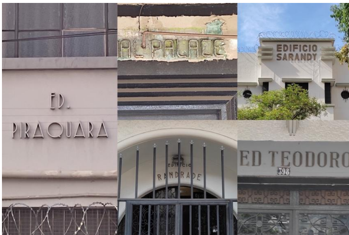
Figura 18 – Distintas intervenções que afetam a leitura dos letreiros
