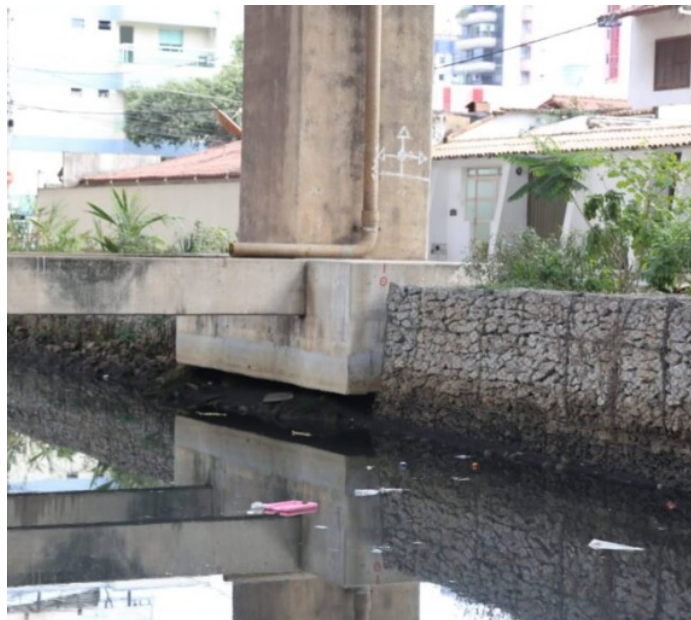
Figura 1: Valão de Vila Velha
